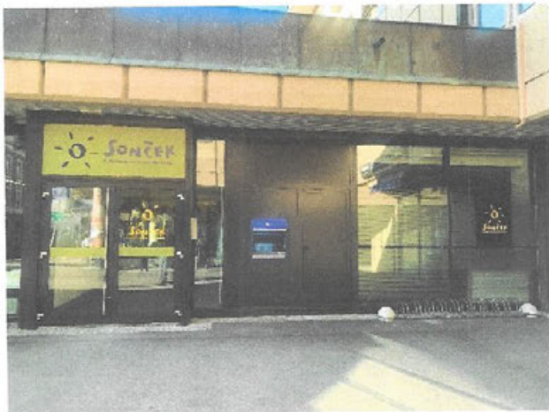
Slika 2 Vhod v nove prostore Glavni trg Maribor
